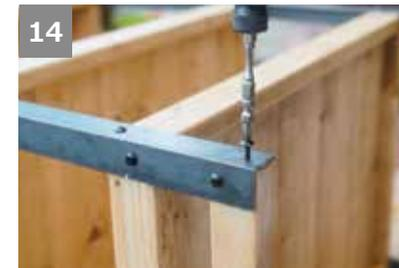
14 **⑥**をアングルの上面に合わせて固定する。タッピングネジで固定する際、左右で開ける位置を少しずらす。
