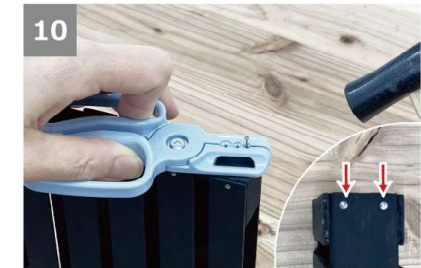
10 ⑨の接着剤が乾いたら、側面から2カ所ずつ小鋸で25mmの⑥を固定する。⑥の板厚が6mmなので、端から3mm部分に小鋸を打つ。 ※合計4カ所になります。
