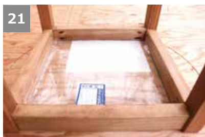
21 本体をひっくり返して、カットしたアクリルを中に置く。
