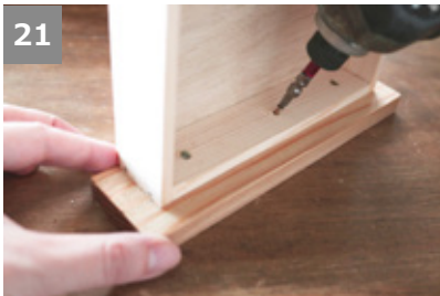
下段引き出しは、③を上下方向は底面合わせ、左右方向は中心に合わせ、極細ビス15mmで固定する。
