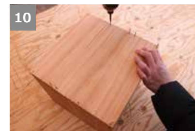
10 ⑨に、箱形になるように、(B)接ぎ板を固定する。
