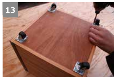
13 底面に鍋タッピングでキャスターを取り付ける。
