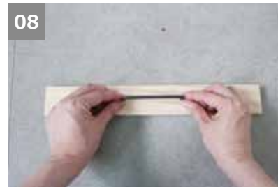
08 ⑧の中心にかすがいを合わせて、印を付ける。
